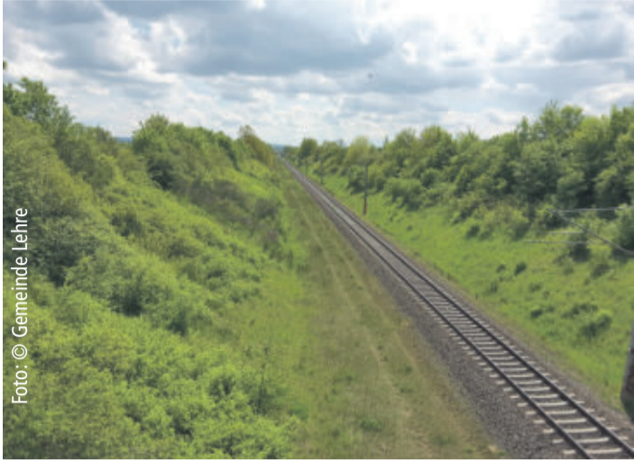
Der zweigleisige Ausbau der Weddeler Schleife zwischen Braunschweig und Wolfsburg beginnt im Herbst.
