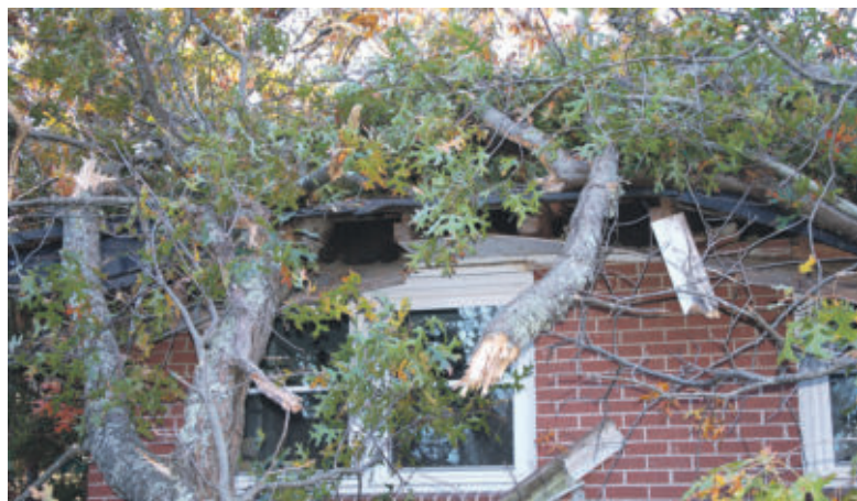
Die meisten Menschen können solche Schäden nicht selbst ausgleichen. In diesem Fall springt eine Wohngebäudeversicherung ein. Foto: DJD/Nürnberger Versicherung/thx
