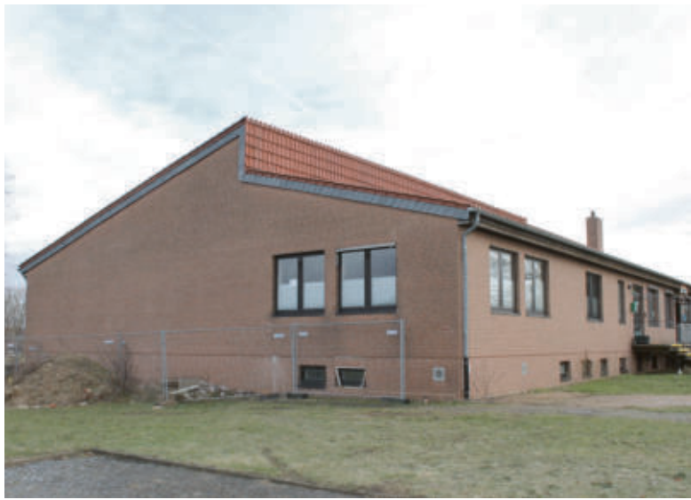
Foto(© Gemeinde Lehre): Die gesamte Dorfgemeinschaftsanlage in Beienrode bedarf einer umfassenden Sanierung.
