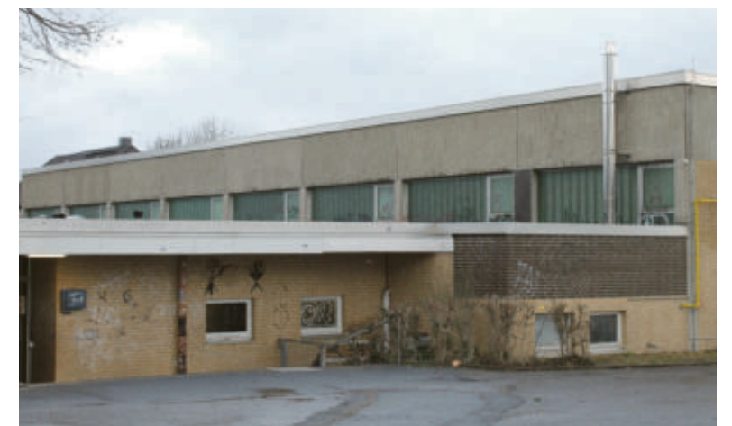
Foto(© Gemeinde Lehre): Die Turnhalle in Flechtorf wird durch einen Neubau ersetzt und nach dessen Fertigstellung abgerissen.
