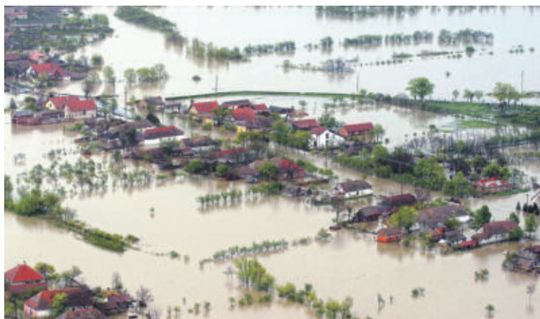
Von Wasser infolge von Überschwemmungen geht inzwischen eine größere Gefahr für Gebäude aus als von Feuer. Foto: DJD/Nürnberger Versicherung/thx
