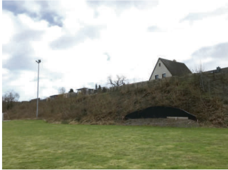
Foto(© Gemeinde Lehre): Die Böschung in Wendhausen wird in diesem Jahr durch Spundwände gesichert.
