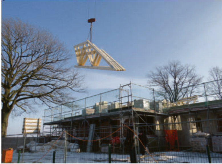
Foto(© Gemeinde Lehre): Kürzlich wurden die Holzelemente für den Dachstuhl der neuen Kita in Essenrode angeliefert.
